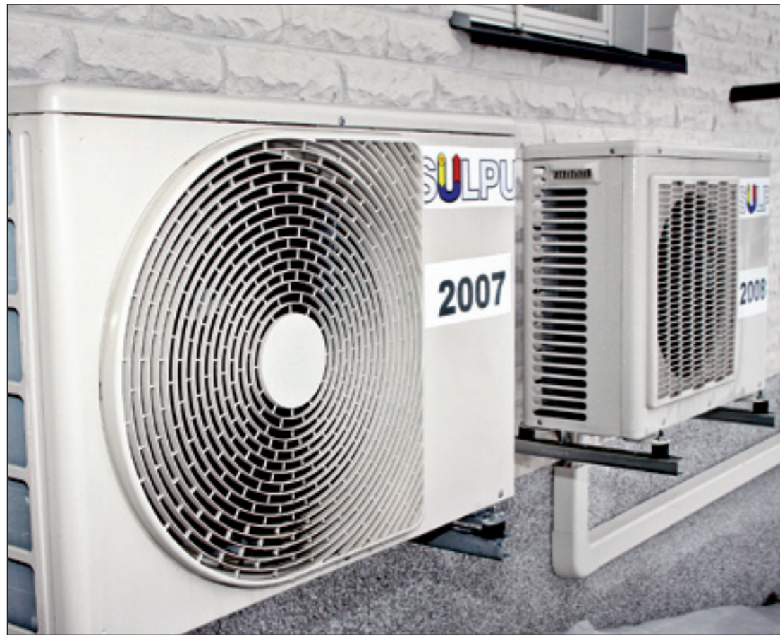
Ulkoyksiköt on sijoitettava riittävästi korkealle ja kiinnitettävä tukevasti. Laitetta on syytä seurata aika ajoin, jotta sen tuuletinyksikköön ei pääse vieraita esineitä.
