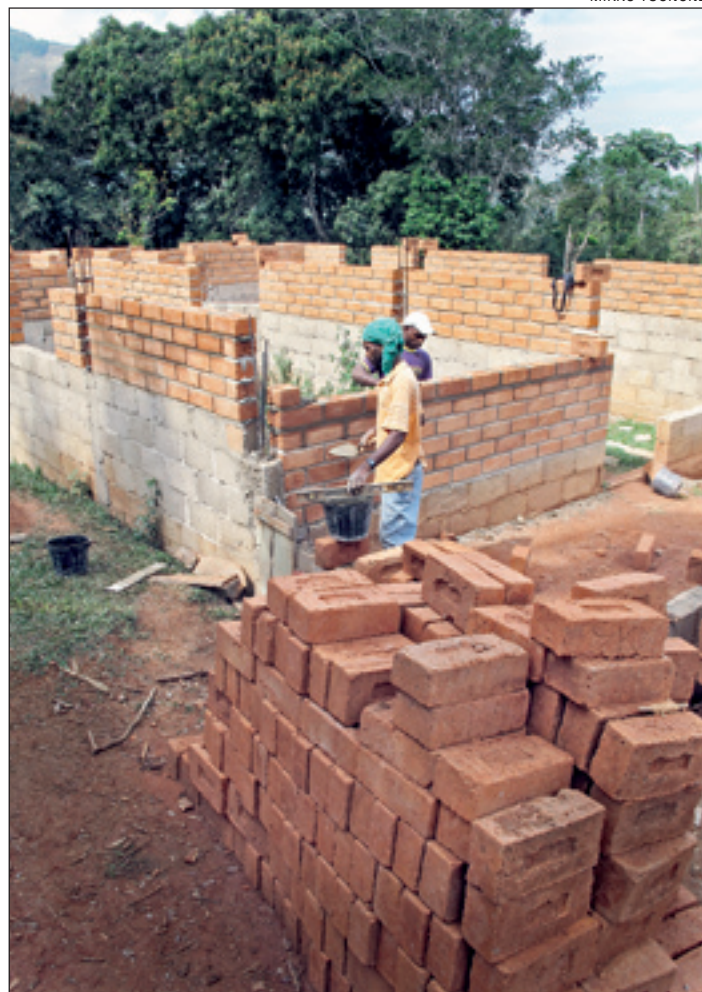
Ruotsalaista luomutaloa: puurunko ja savi-puuhake seos! Isot ikkunat etelään ja maalämpö (kuva vasemmalla). Polttamattomalla savitiilellä muuraamista Dominikaanisen Tasavallan vuoristossa.
