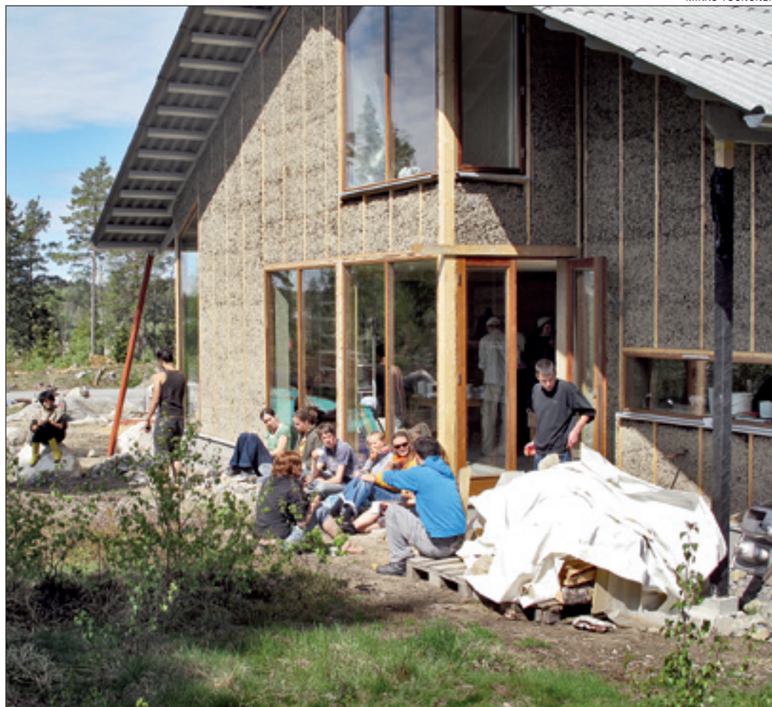
Ruotsalaista luomutaloa: puurunko ja savi-puuhake seos! Isot ikkunat etelään ja maalämpö (kuva vasemmalla). Polttamattomalla savitiilellä muuraamista Dominikaanisen Tasavallan vuoristossa.
