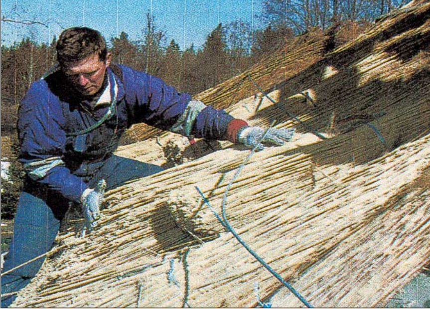
Eläinlääkäri Mihkel Ling Muhun saaresta Virossa latoo standardilyhteistä ruokokattoa keväällä 2003. Kuva Kotiseutusanomatt.
