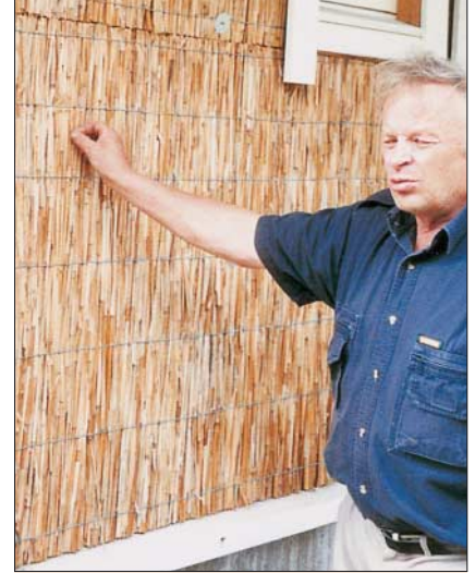
”Monet ovat sanoneet, että jätä rappaamatta, mutta onhan tämä ruokomatto ajan oloon liian hentoinen”, tuumii Usko Paananen Berger-seinänsä ääressä.
