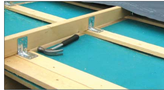
Sininen Runkoleijona™ on kestävä tuulensuojalevy, jonka ominaisuudet pääsevät oikeuksiinsa erityisesti yksirunkojärjestelmällä rakennettujen seinien tuulensuojalevynä. Kuvan lämpöeristetyssä katossa Runkoleijona™ toimii paitsi tuulensulkuna myös tehokkaana kondenssivesisuojana katon eristemateriaalille.
