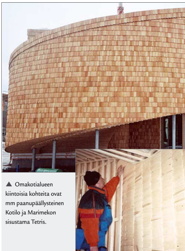
Maaliskuun lopussa Kotilon ulkuvuorauksen lehtikuusipaanut ▲ ovat jo pitkään olleet paikoillaan. Sisältä löytyy haapapäreverhoilu.
