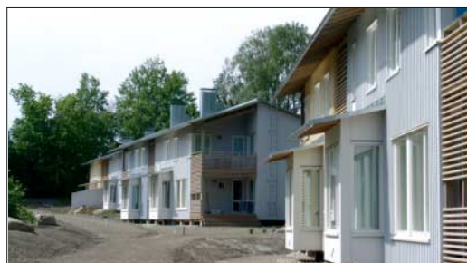
Bromarvin ekokylä. Kuvassa puurakenteisia kerrostaloja.
