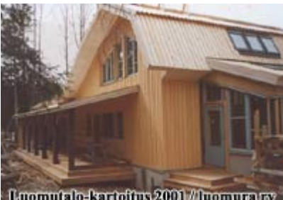
kuva 4. Ekoateljeen metsänpuoli on rakennettu kutterinpuruelementeistä ja pinnoitettu perinteisellä lomalaudalla sekä päreellä. Katto on urahöylätystä laudasta ja terassirakenteet lämpökäsitellystä puusta
