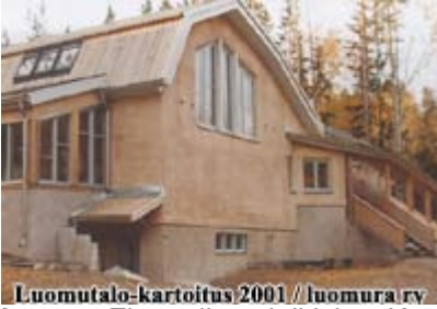
kuva 1. Ekoateljeen julkisivu. Kantava puurunko, olkipaalieristyksen ja savi/ kalkkirappaukset
