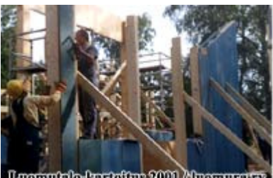
kuva 5. Kutterinpuruelementeistä syntyy valmiista kantavaa seinää nopeasti
