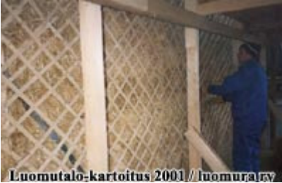
kuva 2. Olkipaalieristeisen seinän pinnassa rappausalustana käytettiin mm. puusäleikköä, tavallista rappausverkkoa ja järviruokomattoa
