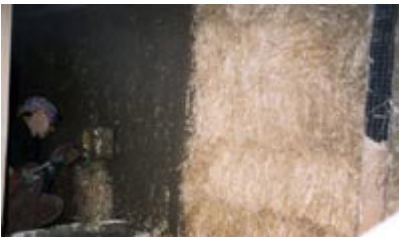
kuva 3. Savirappaukset käy tehokkaimmin kauharuiskulla ja ilmanpaineella. Niillä savi työntyy syvemmälle oljen väleihin kuin käsin rappaamalla
