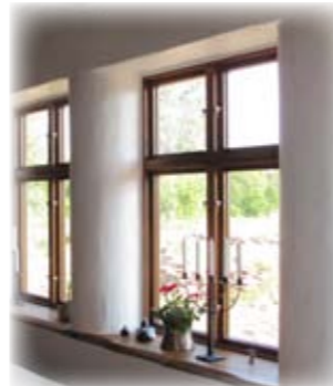
Olkipaalisella syntyy helposti pyöreätkin muodot. Ja katso noita ikkunalautoja!
