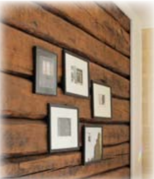
Hirsiseinä on kuurattu mäntysavolla ja vahattu Osmon konjaksiväyisellä vahalla.
