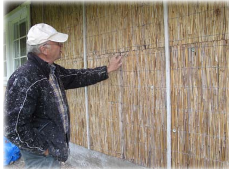
Järviuonosta ommeltua Bergerlevyä seinässä. Levy toimii myös lisäeristeenä ja rappaustalustana.
