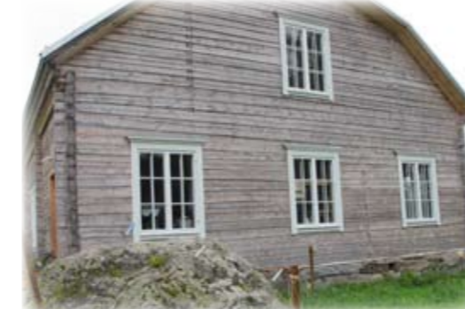
Luomuhirsitalossa Kokkolassa tuvan hirsipinnat on jätetty käsittelemättä. Hirret on piiluttu käsin, mikä parantaa akustiikkaa.
