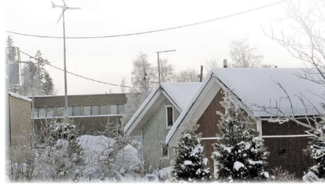
3,5 kW tehoinen Windspot pientuulivoimala Tampereella.
